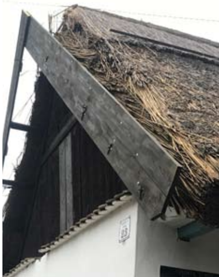
A széldezzkák cseréje, a nádfedél javítása előtt (Fotó: Rajosné Lapid Eszter)
