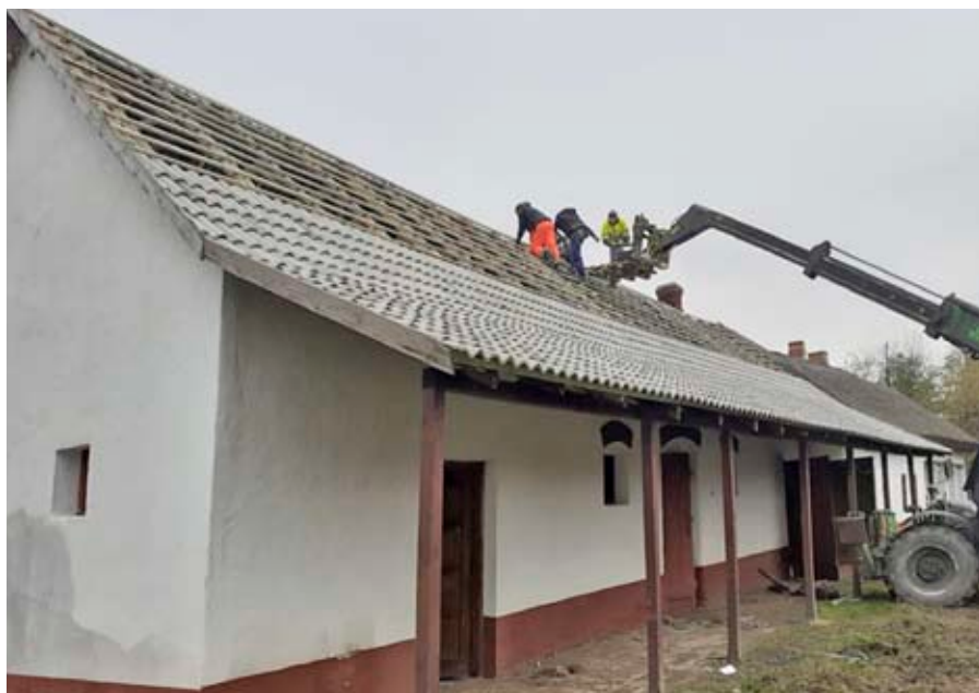
Az Egyeki Tájház gazdasági épületének tetőcseréje (Fotó: Egyeki Tájház)
